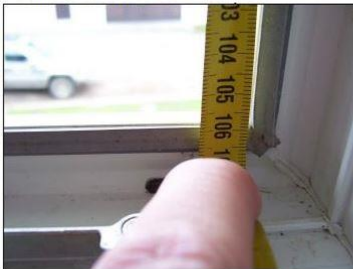
2 - zaměření výšky ( měřte na 3 místech )
