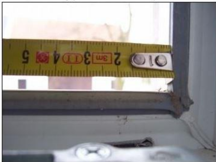
1 - zaměření šířky ( měřte na 3 místech )
